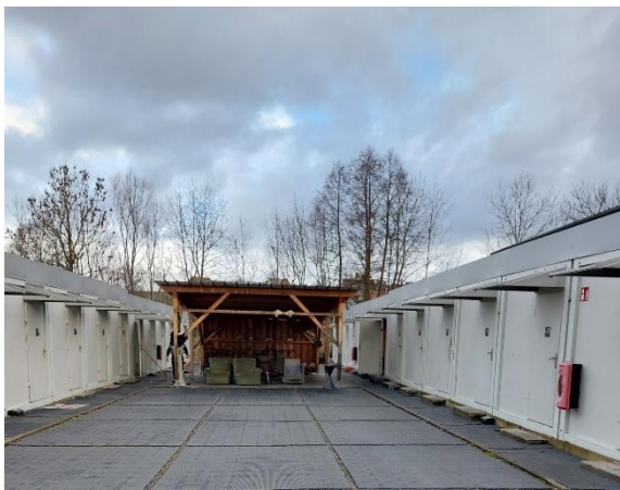
VU Containerunterkunft, Oberstenfeld
